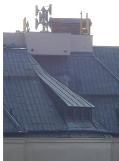
stávající provedení vikýře TYP 10
