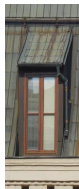
stávající provedení vikýře TYP 4
